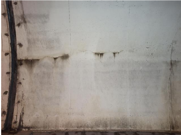
Slika 26: Kampada 63 - PUKOTINE I IZLUŽIVANJE
