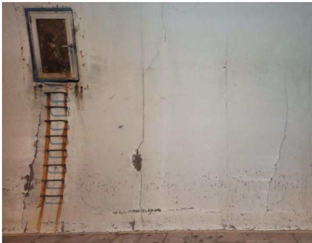
Slika 10: Kampada 5 - KOROZIJA, PUKOTINE, VLAŽENJE I LJUŠTENJE BETONA
