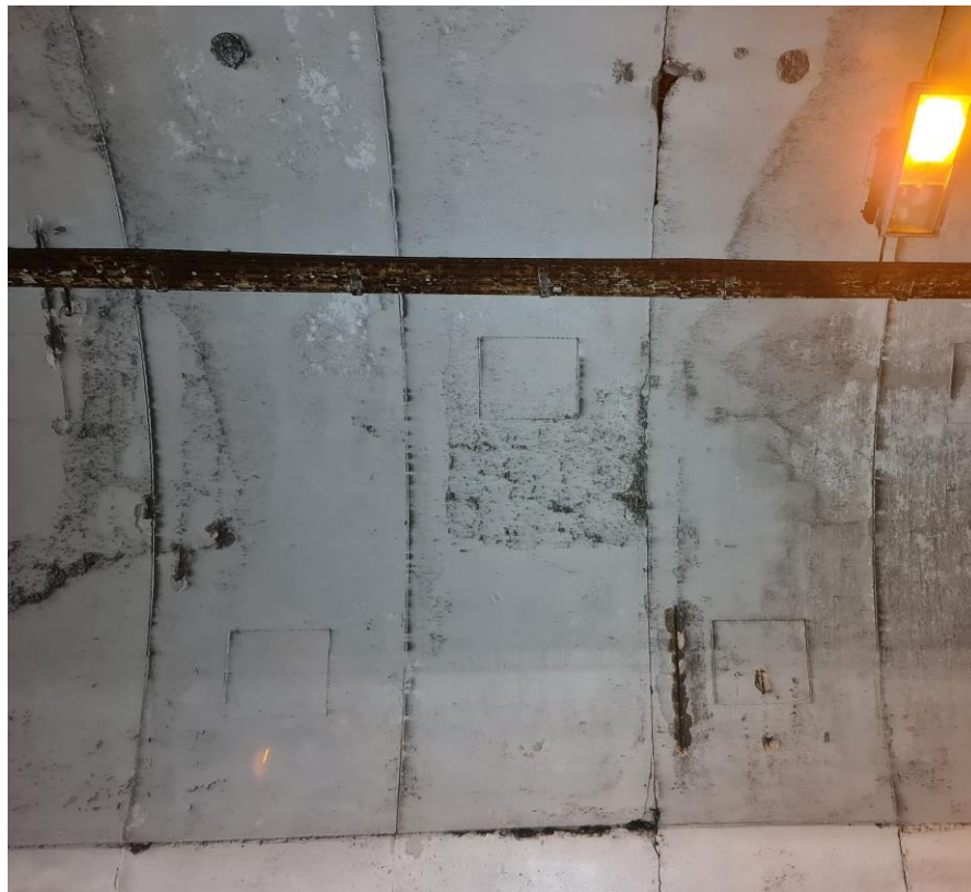
Slika 52: Kampada 147 - SEGREGACIJA, ARMATURA BEZ ZAŠITNOG SLOJA I ODLAMANJE BETONA
