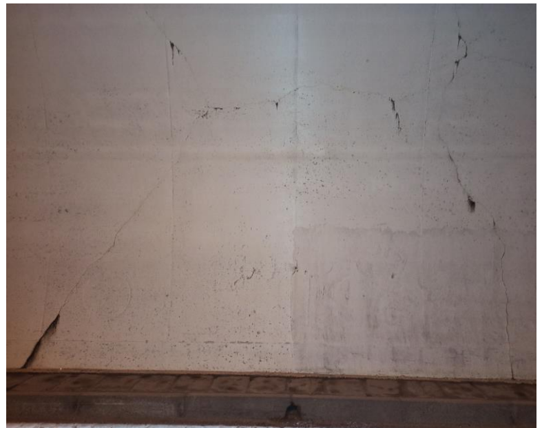
Slika 19: Kampada 35 - PUKOTINE I ARMATURA
