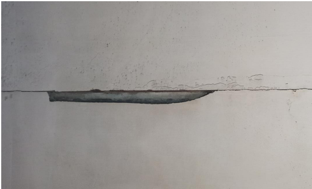
Slika 31: Kampada 69-70 - LJUŠTENJE PREMAZA I VLAŽENJE
