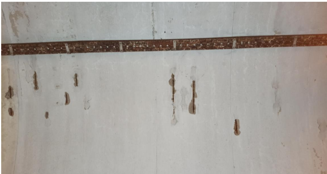
Slika 6: Kampada 3 - ARMATURA I LJUŠTENJE BETONA
