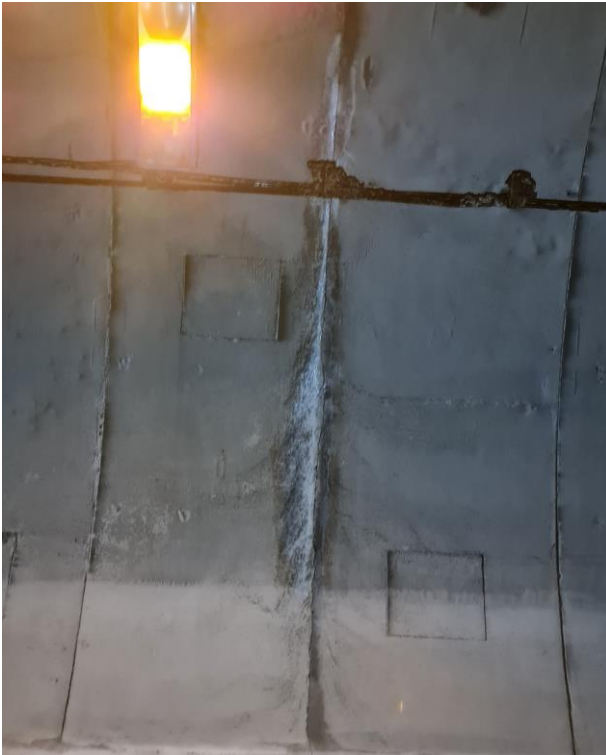
Slika 63: Kampada 188 - 189 - PUKOTINA, IZLUŽIVANJE I ODLAMANJE BETONA
