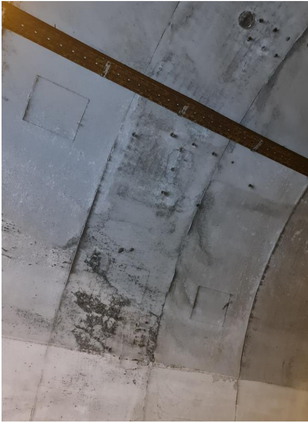
Slika 48: Kampada 130 - SEGREGACIJA BETONA
