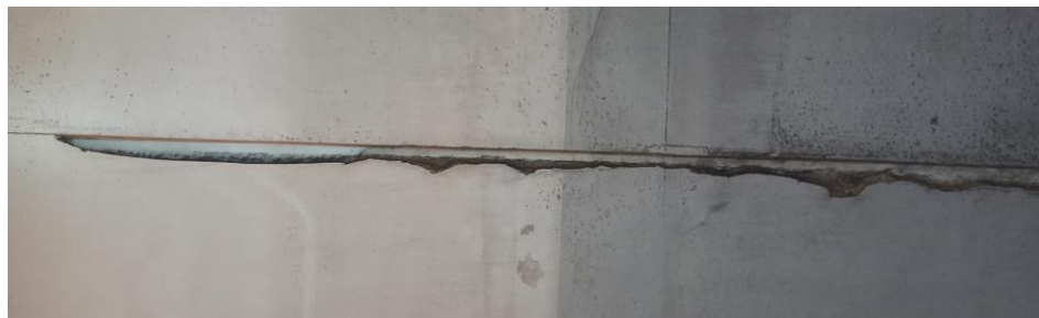
Slika 33: Kampada 75 - PUKOTINE, LJUŠTENJE PREMAZA I BETONA, VLAŽENJE
