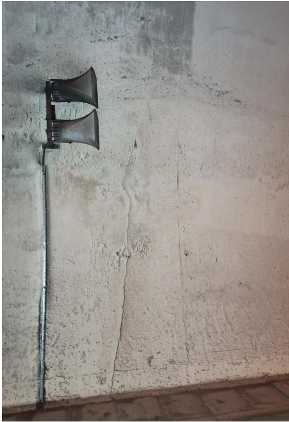
Slika 16: Kampada 22 - PUKOTINE I KOROZIJA
