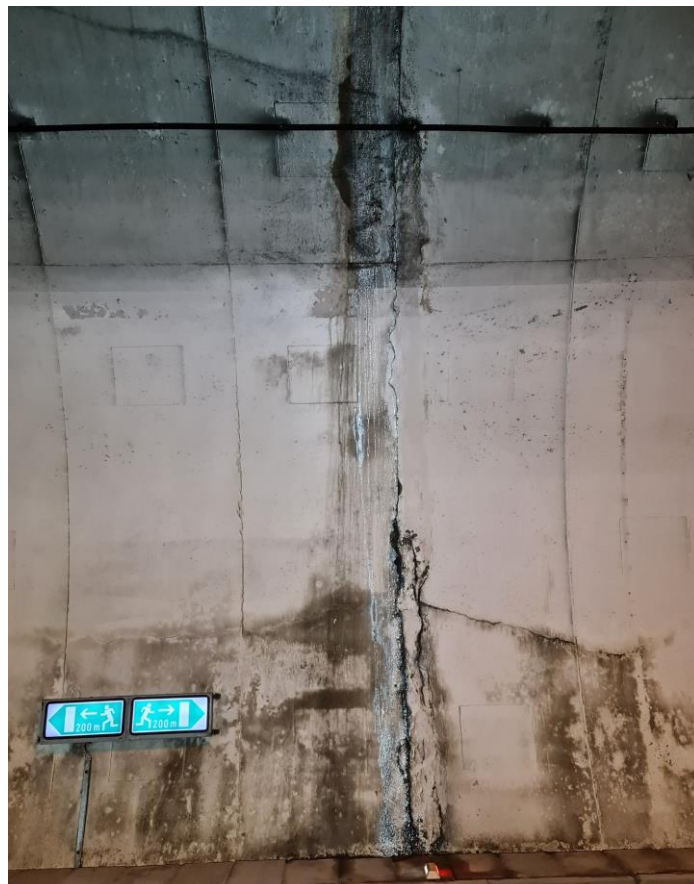
Slika 44: Kampada 121 - PUKOTINA I IZLUŽIVANJE
