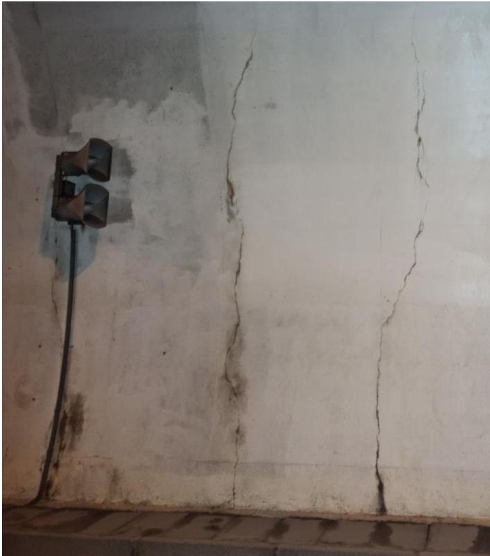
Slika 24: Kampada 57 - IZLOŽENA ARMATURA, KOROZIJA, PUKOTINE I VLAŽENJE
