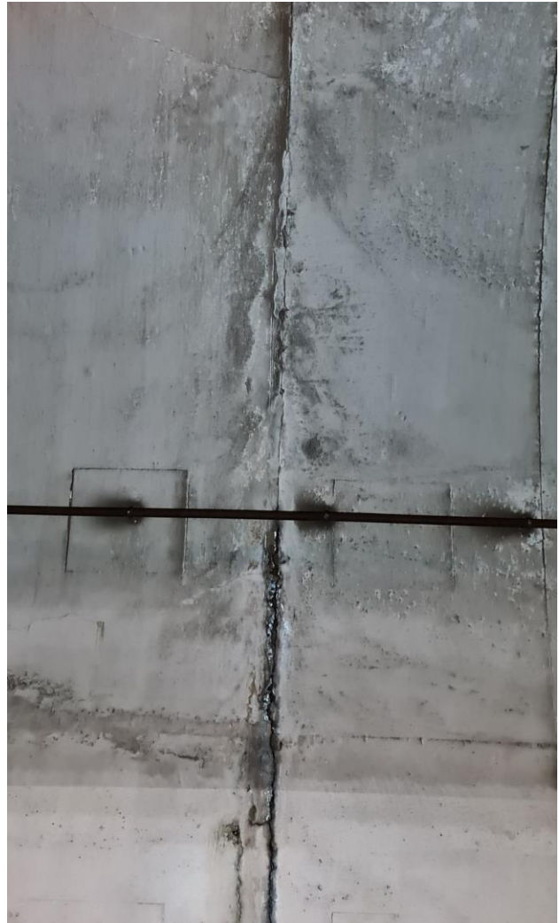
Slika 55: Kampada 162-163 - PUKOTINA, VLAŽENJE I ODLAMANJE BETONA
