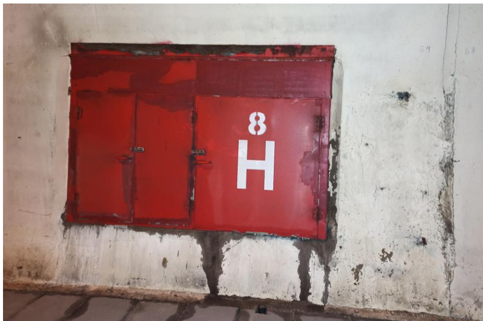
Slika 30: Kampada 69 - LJUŠTENJE PREMAZA I VLAŽENJE
