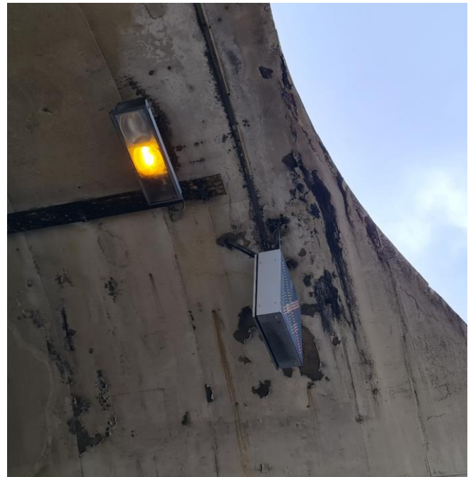
Slika 66: Izlazni portal - PUKOTINE I LJUŠTENJE BETONA I PREMAZA
