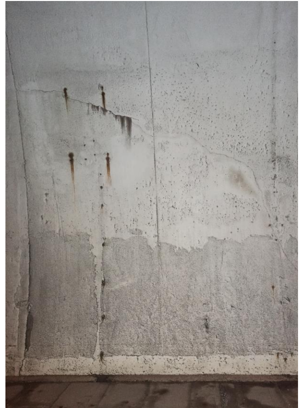
Slika 16: Kampada 22 - PUKOTINE I KOROZIJA
