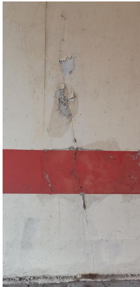
Slika 5: Kampada 2 - PUKOTINE I LJUŠTENJE PREMAZA
