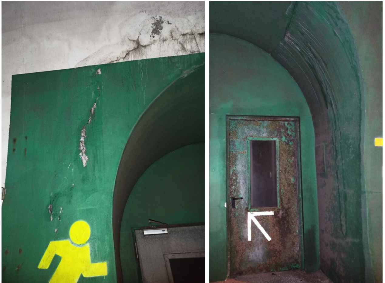
Slika 33: Kampada 75 - PUKOTINE, LJUŠTENJE PREMAZA I BETONA, VLAŽENJE
