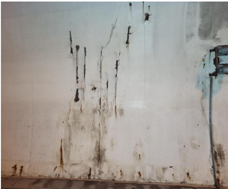
Slika 25: Kampada 57 - IZLOŽENA ARMATURA, KOROZIJA, PUKOTINE I IZLUŽIVANJE
