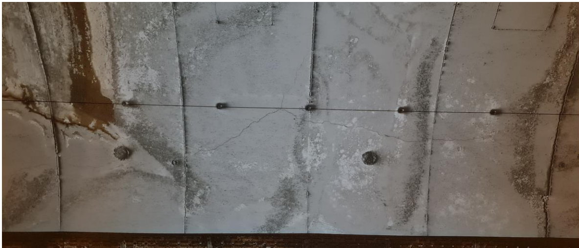
Slika 44: Kampada 121 - PUKOTINA I IZLUŽIVANJE
