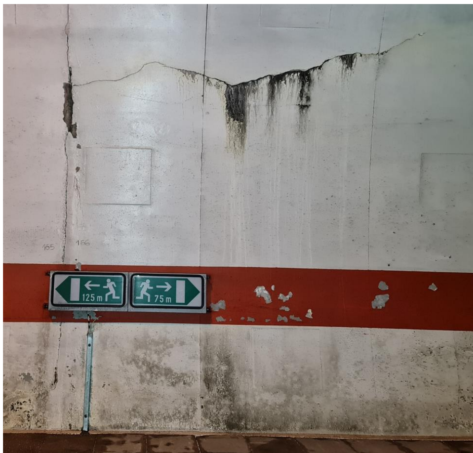
Slika 57: Kampada 166 - PUKOTINA, IZLUŽIVANJE I LJUŠTENJE PREMAZA I BETONA
