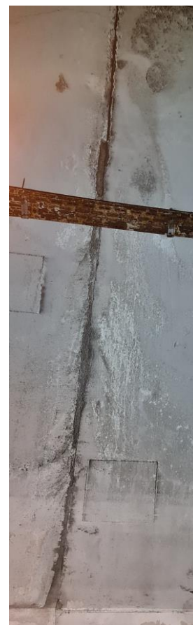
Slika 57: Kampada 166 - PUKOTINA, IZLUŽIVANJE I LJUŠTENJE PREMAZA I BETONA
