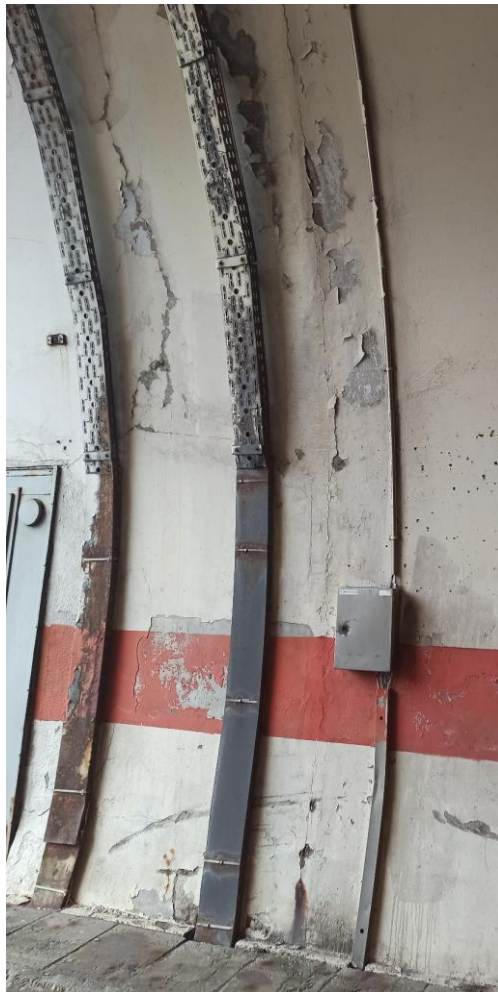
Slika 5: Kampada 2 - PUKOTINE I LJUŠTENJE PREMAZA
