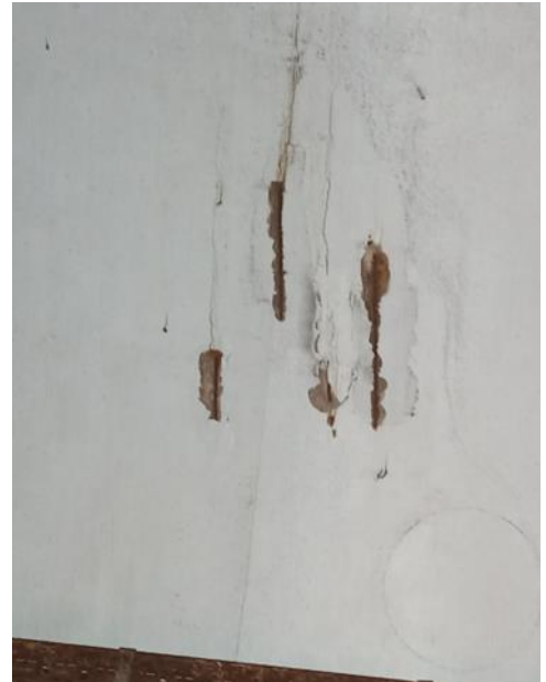
Slika 25: Kampada 57 - IZLOŽENA ARMATURA, KOROZIJA, PUKOTINE I IZLUŽIVANJE
