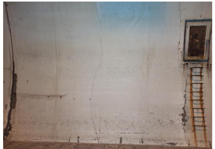
Slika 10: Kampada 5 - KOROZIJA, PUKOTINE, VLAŽENJE I LJUŠTENJE BETONA
