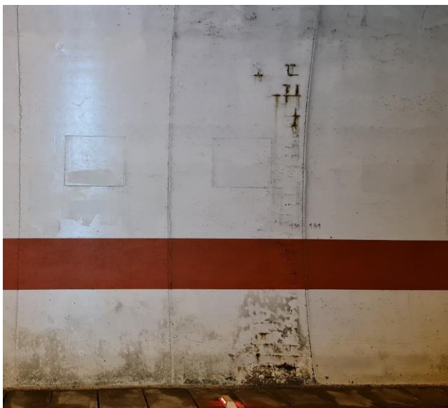
Slika 47: Kampada 130 - ARMATURA BEZ ZAŠITNOG SLOJA
