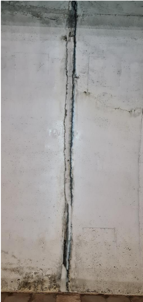
Slika 55: Kampada 162-163 - PUKOTINA, VLAŽENJE I ODLAMANJE BETONA
