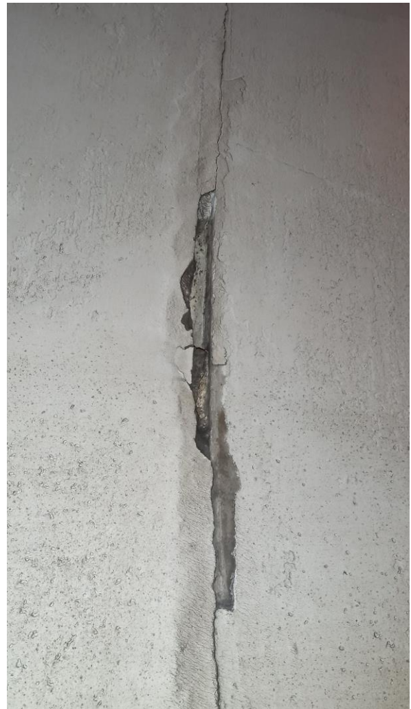
Slika 14: Kampada 18 - LJUŠTENJE BETONA NA SPOJNICI
