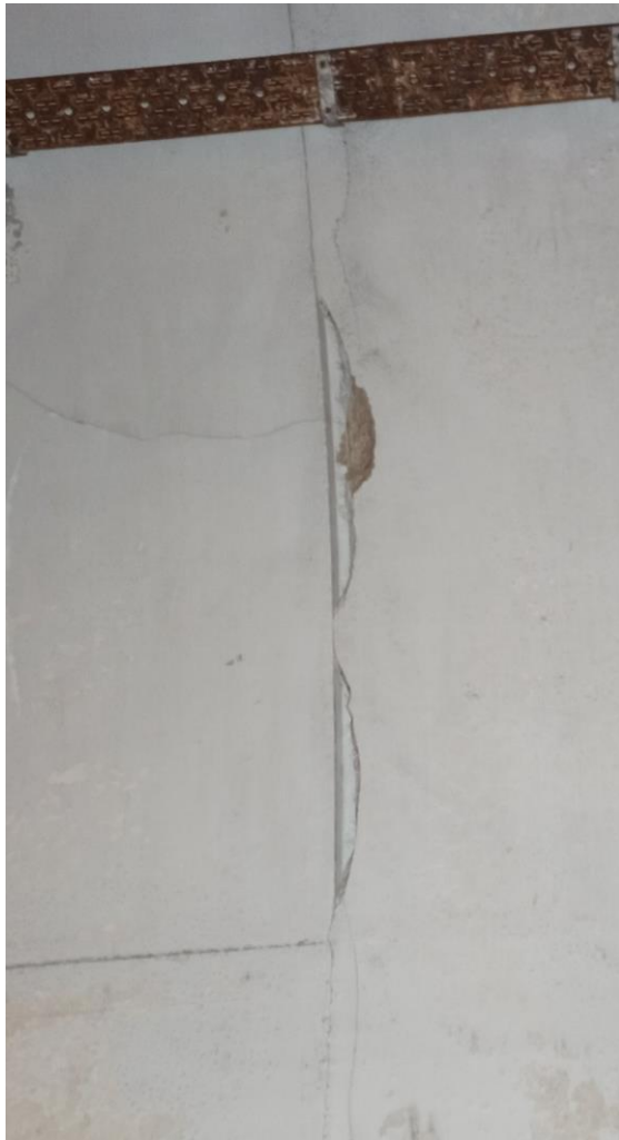
Slika 14: Kampada 18 - LJUŠTENJE BETONA NA SPOJNICI
