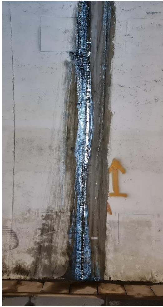
Slika 42: Kampada 115-116 - VLAŽENJE I IZLUŽIVANJE
