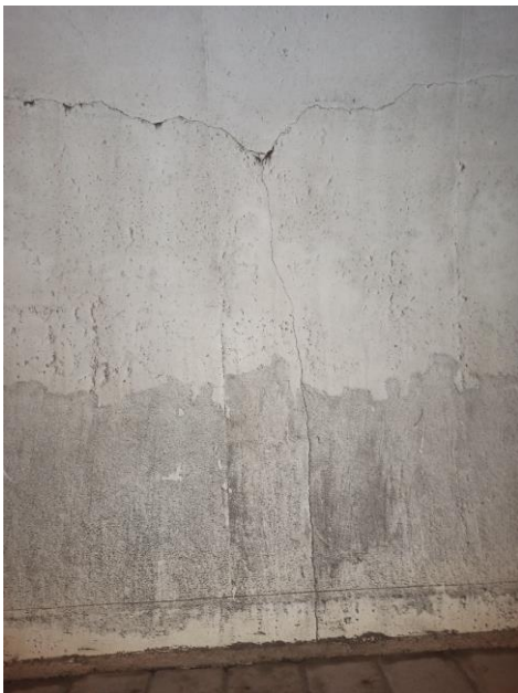
Slika 16: Kampada 22 - PUKOTINE I KOROZIJA
