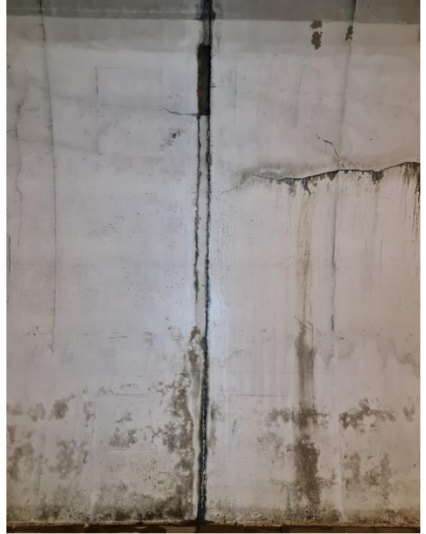
Slika 63: Kampada 188 - 189 - PUKOTINA, IZLUŽIVANJE I ODLAMANJE BETONA
