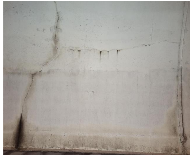
Slika 26: Kampada 63 - PUKOTINE I IZLUŽIVANJE
