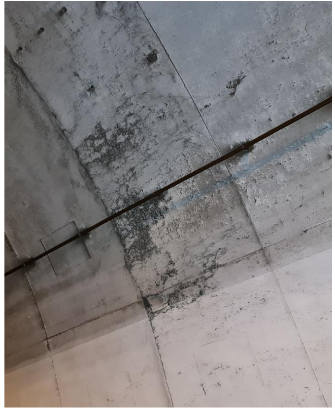
Slika 48: Kampada 130 - SEGREGACIJA BETONA
