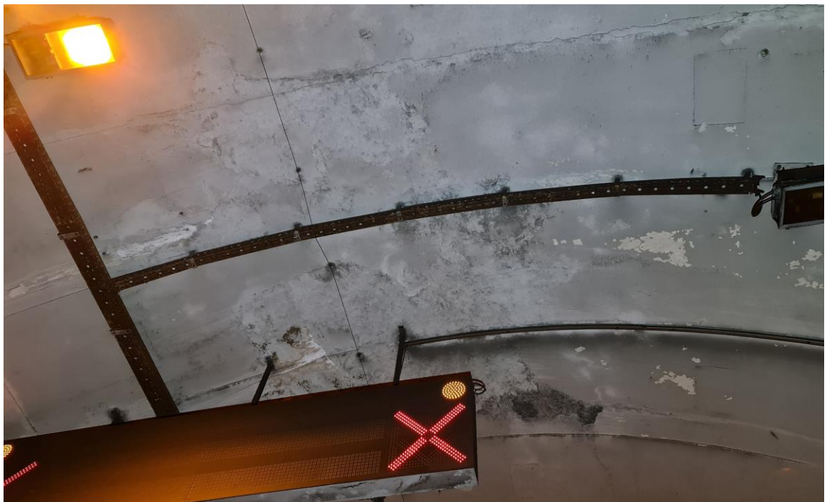
Slika 40: Kampada 98 - VLAŽENJE, IZLUŽIVANJE I LJUŠTENJE PREMAZA
