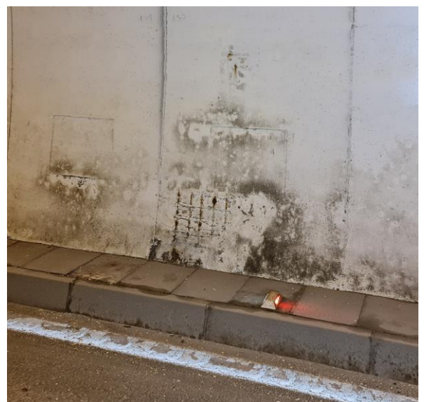
Slika 47: Kampada 130 - ARMATURA BEZ ZAŠITNOG SLOJA
