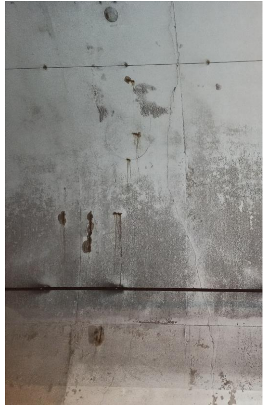
Slika 24: Kampada 57 - IZLOŽENA ARMATURA, KOROZIJA, PUKOTINE I VLAŽENJE
