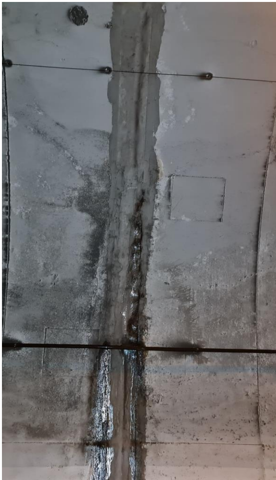
Slika 42: Kampada 115-116 - VLAŽENJE I IZLUŽIVANJE
