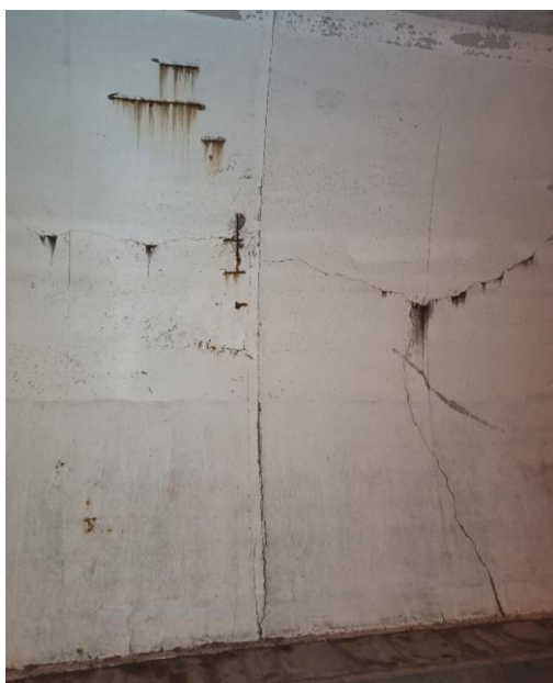
Slika 19: Kampada 35 - PUKOTINE I ARMATURA
