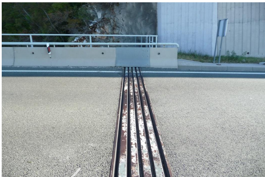
Slika 1.2-3 Pogled na istočnu prijelaznu napravu (smjer Krk)
