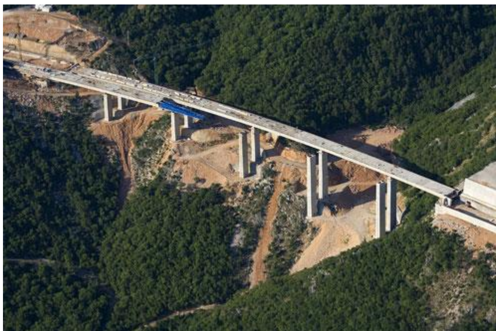
Slika 1.2-1 Pogled vijadukt Kuk za vrijeme izvedbe.
