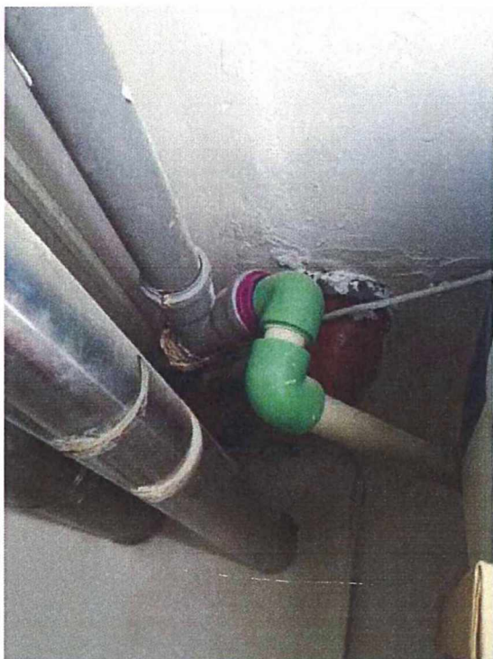
Detalj spoja odvodnje umivaonika i pisoara u prizemlju prije priključka na glavnu odvodnu cijev
