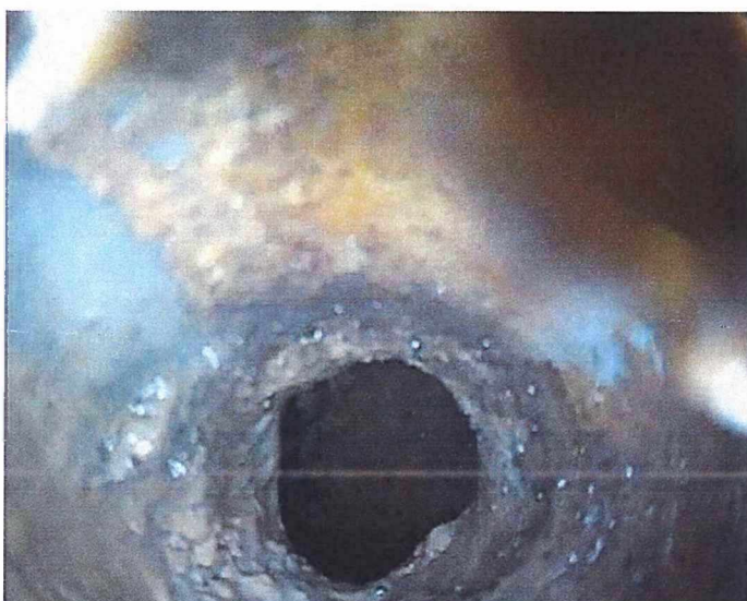
Unutrašnjost spoja odvodne cijevi umivaonika i pisoara u muškom WC-u na 6. katu na vertikalu
