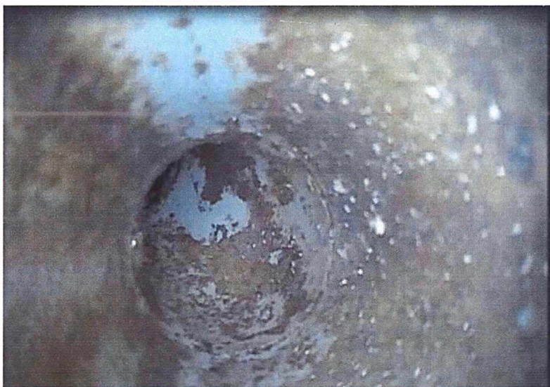
Unutrašnjost odvodne cijevi umivaonika i pisoara u muškom WC-u na 2. katu
