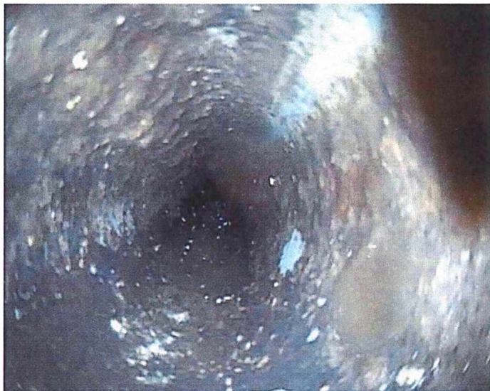
Unutrašnjost odvodne cijevi umivaonika i pisoara u muškom WC-u na 4. katu
