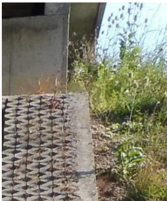
Spoj rubnih elemenata opločenja s AB pasicom, zidom upornjaka, te spoja na vrhu pokosa (lom kosina)
