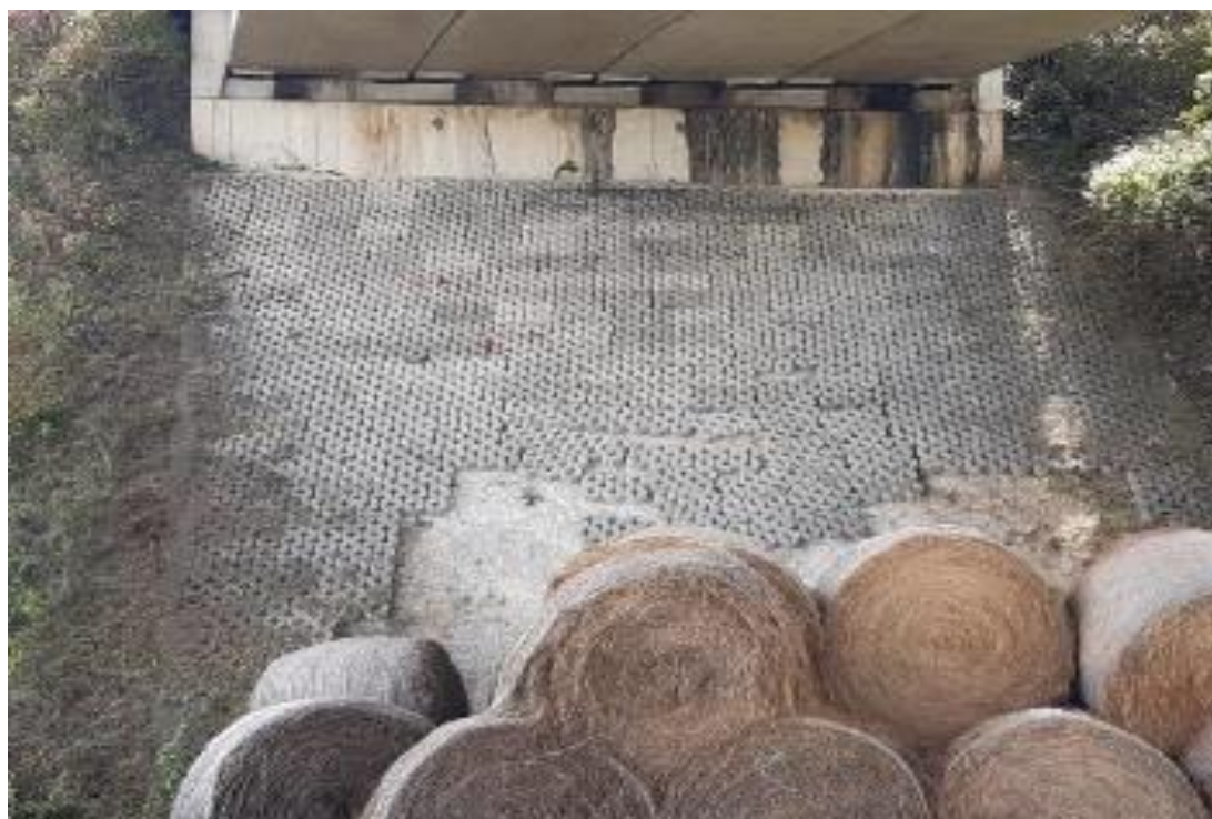
POSTOJEĆE STANJE POKOSA UPORNIJAKA NADVOŽNJAKA BOBOVICA U km 2+326 - DESNO
