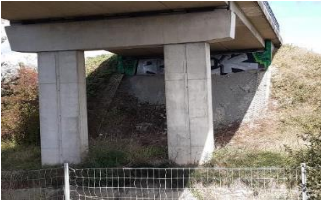
POSTOJEĆE STANJE POKOSA UPORNJAKA NADVOŽNJAKA FARKAŠEVAC U km 5+732 - LIJEVO
