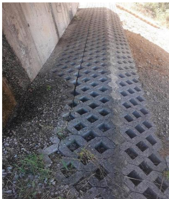
Spoj rubnih elemenata opločenja s AB pasicom, zidom upornjaka, te spoja na vrhu pokosa (lom kosina)
