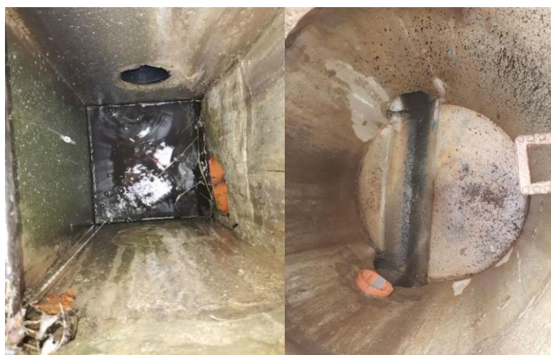
Slika 4. Km 0+088,89, postojeće revizijsko okno RO_4 i pripadajući slivnik SL_1 oborinske kanalizacije
