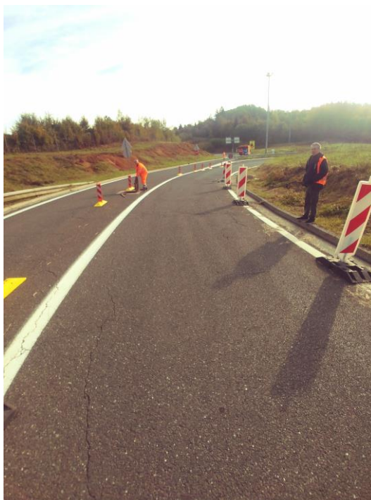
Slika 1. Pogled na trasu kraka u smjeru AC A1 i postojeće revizijsko okno RO_2 u kolniku
