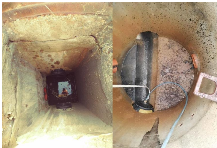
Slika 3. Km 0+059,05, postojeće revizijsko okno RO_3 i pripadajući slivnik SL_1 oborinske kanalizacije
