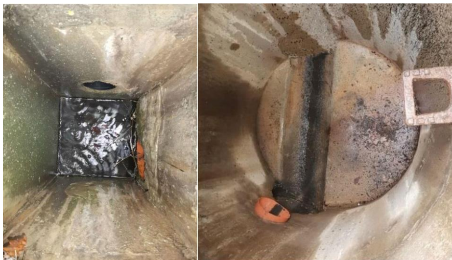
Slika 1. Km 0+000,00, postojeće revizijsko okno RO_1 i pripadajući slivnik SL_1 oborinske kanalizacije
