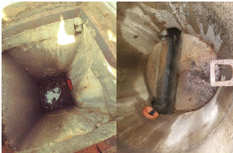
Slika 2. Km 0+026,93, postojeće revizijsko okno RO_2 i pripadajući slivnik SL_1 oborinske kanalizacije
