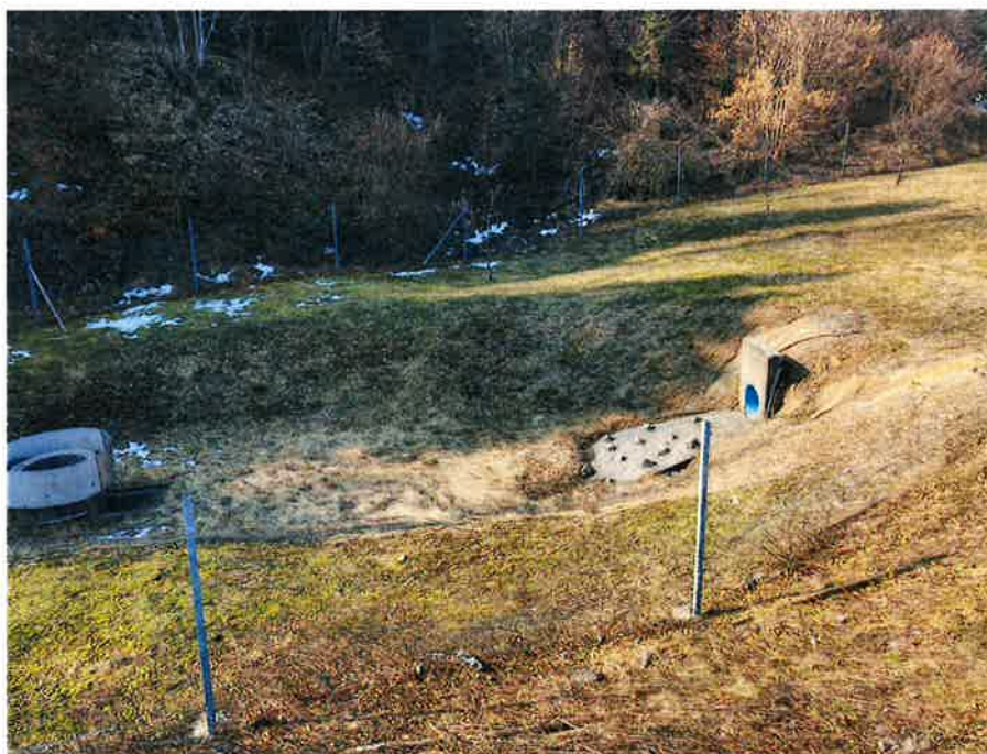
Slika 6. Izljev u teren ( iz separatora )
