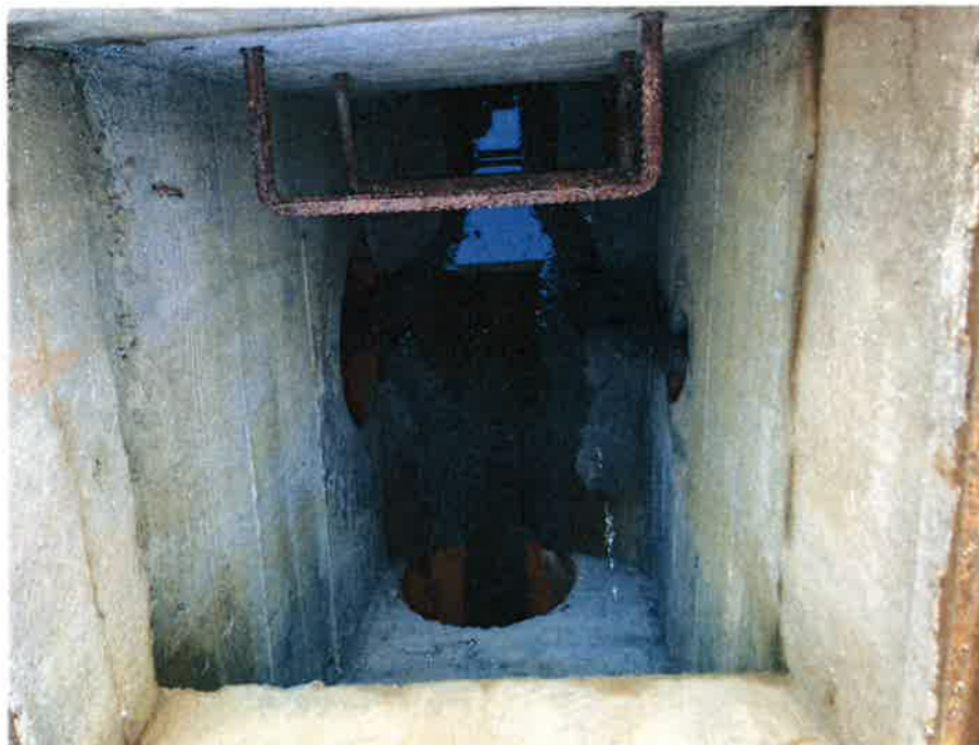
Slika 5. Karakteristično revizijsko okno za uljane odvodnje RO_Z4
