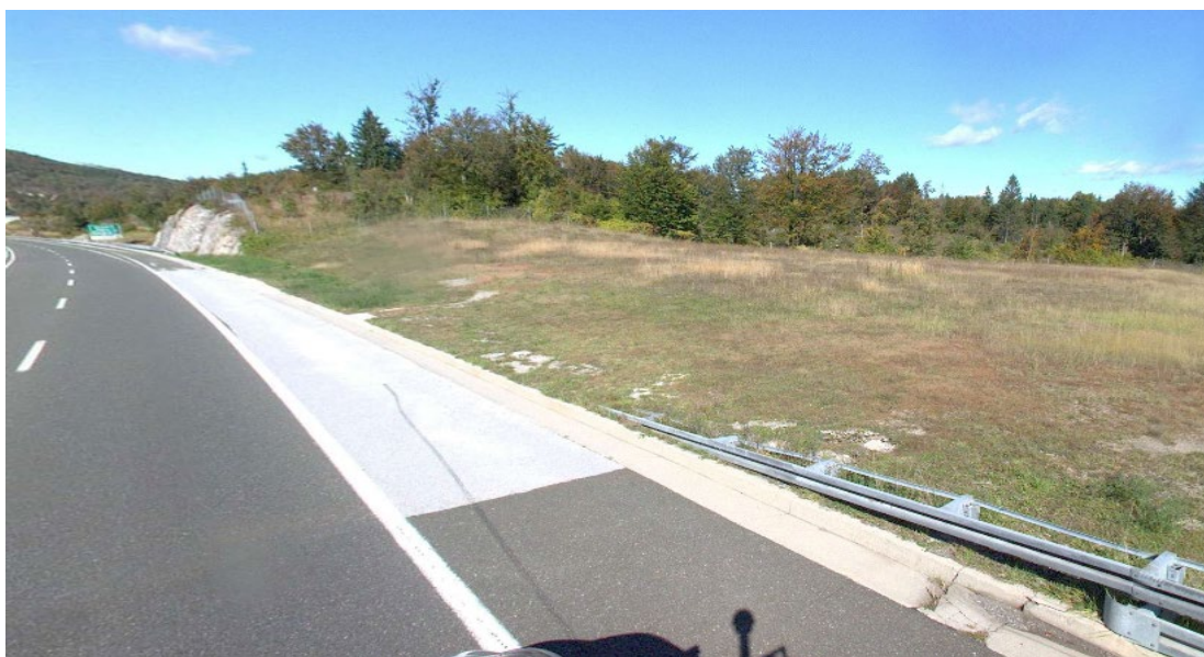
Slika 2. Prikaz postojećih odbojnih ograda uz rub kolnika u stacionaži cca km 102+500,00
