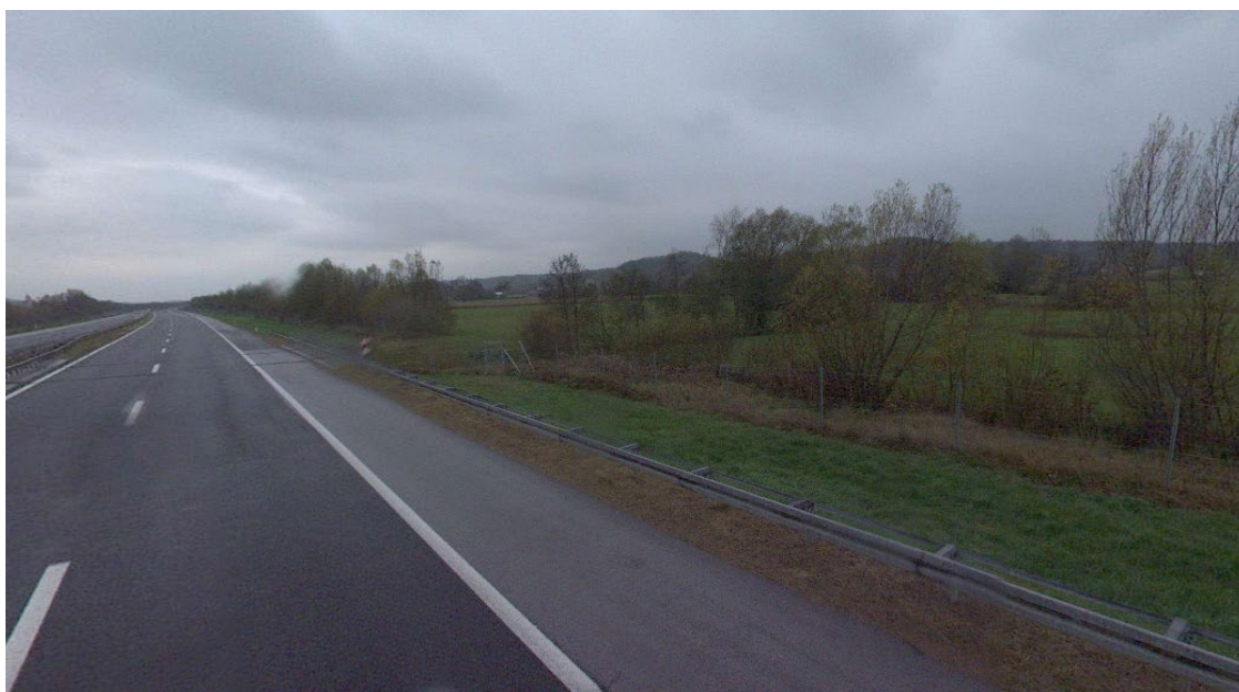
Slika 3. Prikaz postojećih odbojnih ograda uz rub kolnika u stacionaži cca km 62+460,00
