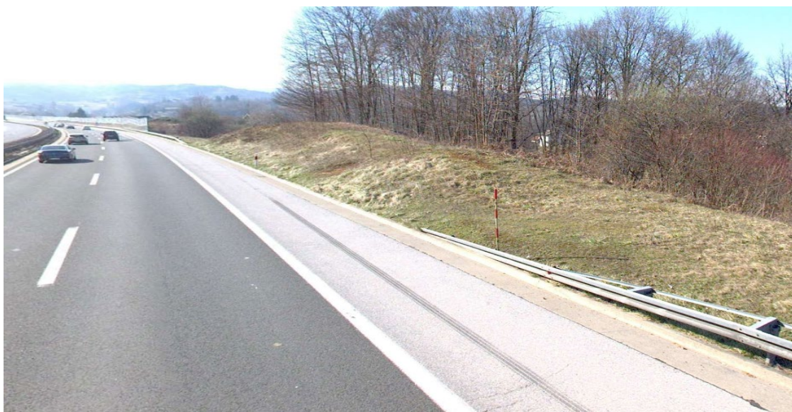
Slika 1. Prikaz postojećih odbojnih ograda uz rub kolnika u stacionaži cca km 44+600,00
